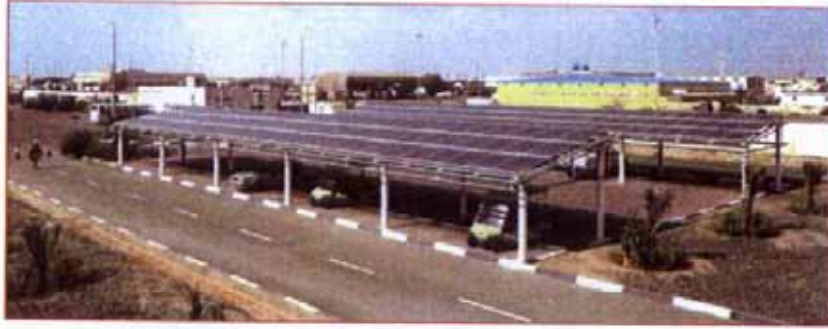
شكل 1 منظومة ألواح شمسية سعة 36 كيلوواط في منطقة المصفح بضواحي مدينة أبوظبي
