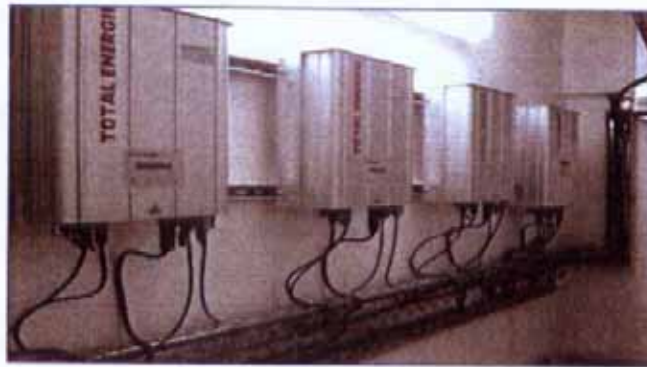
شكل 3 أجهزة عاكسات التيار التي تتصل بالشبكة بعد تحويل التيار المستمر القادم من الألواح الشمسية إلى تيار متناوب.
